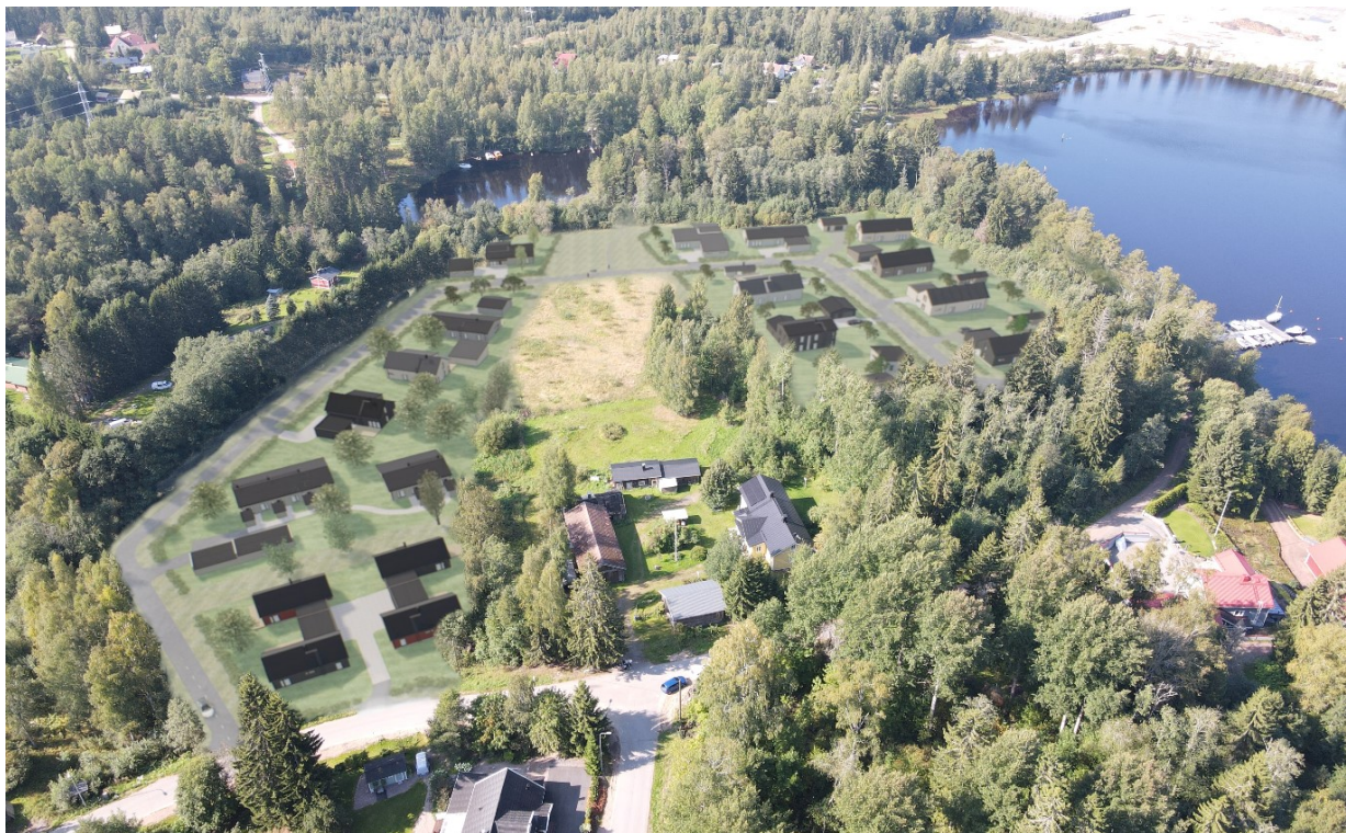
Havainnekuva idästä, uudisrakentaminen sijoittuu Ranta-Niskalan raitin varrelle. Edessä keskellä Yli-Niskala. Rakentamisesta vapaaksi jäävä VL-alue muodostaa näkymäakselin Yli-Niskalan tilalta Pappilanjoelle. Yli-Niskalan kokonaisuus säilyttää merkityksensä maisemassa. Rantapuusto kehystää uutta asuinalueetta.
